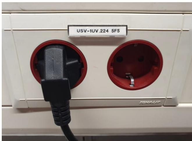
**Abb. 6:** Steckdosen der USV-Anlage (rot)
