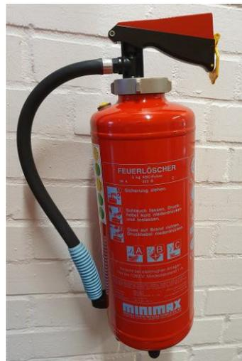
**Abb. 3:** Pulverlöscher in der Nähe der Sicherungskästen auf den Fluren
